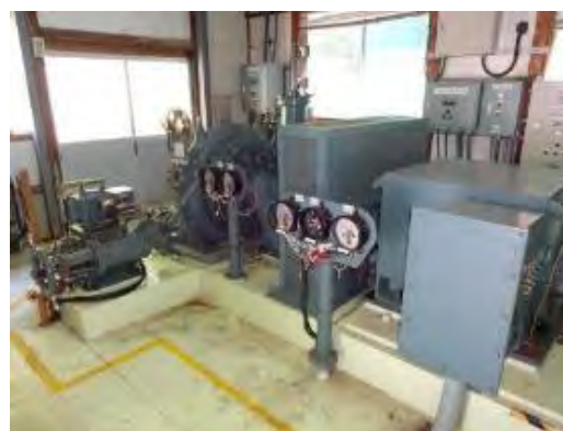
既設水車発電機（横軸フランシス）
