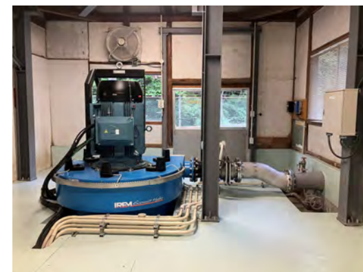
新設水車発電機（縦軸ペルトン）
